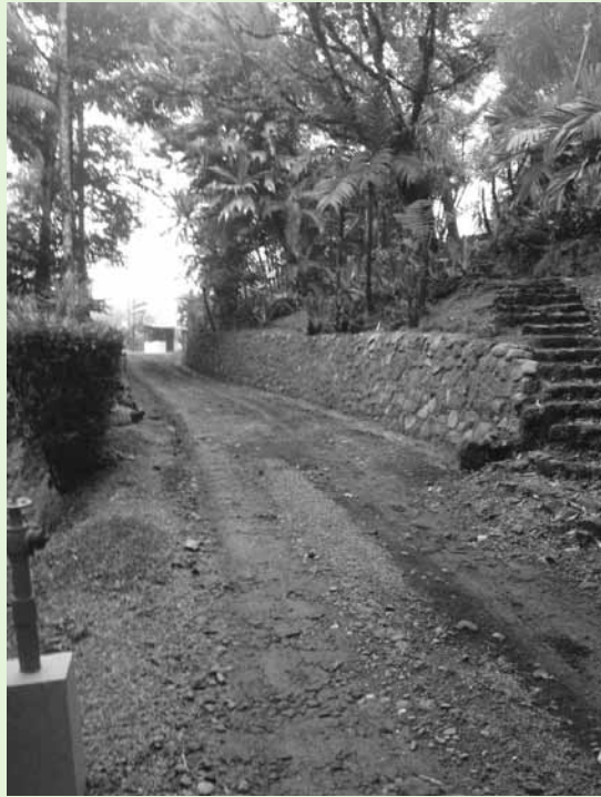
The new Las Cruces wall. Photo Zak Zahawi.
