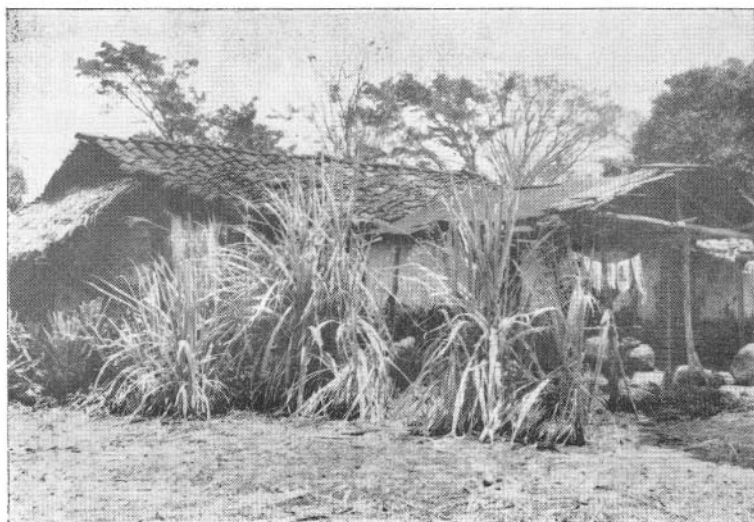
Fig. 2. Casa de habitación del paciente. Arriba: fachada de la casa. Abajo: vista desde atrás. (Fotos A. Trejos).
